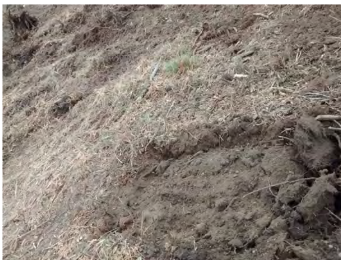
Detalle de la casilla de 60 x 60 x 60 cm preparada con retroexcavadora y lista para plantación, monte Gándaras de Castro, segunda repoblación.
